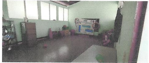
FOTO: PINTURA EN AULAS INTERIOR Y EXTERIOR
