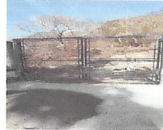
FOTO 4: SUSTITUCION E INTALACION DE PORTON
