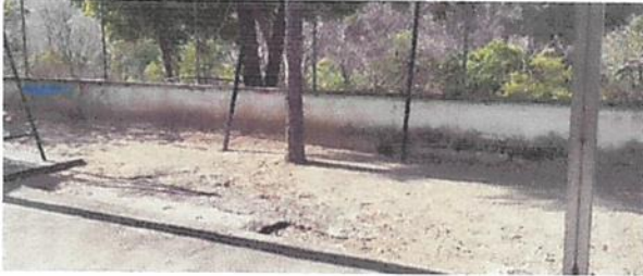
FOTO 1: LOSA DE PATIO 8 CM DE ESPESOS
