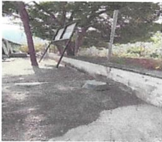
FOTO: PINTURA EN MURO PERIMETRAL
