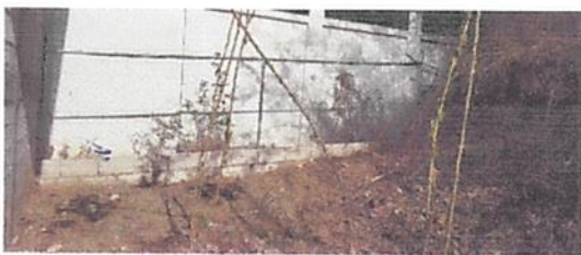
FOTO 5: SUSTITUCION DE MURO PERIMETRAL
